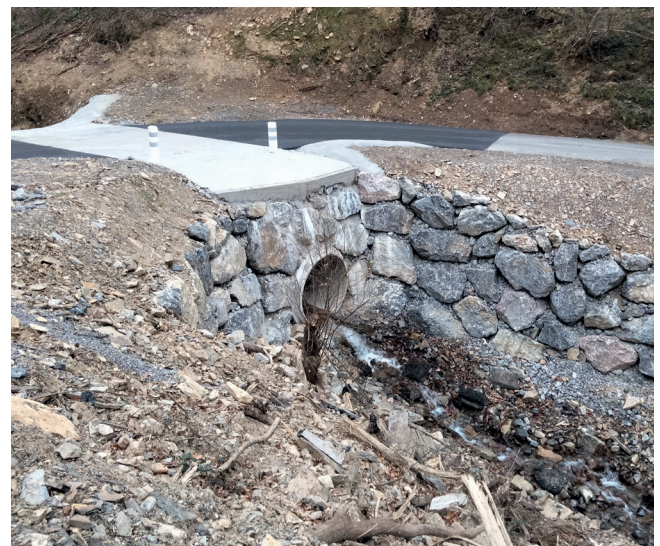
Belexiko beheko aldea obren ondotik- Bas Belexi après les travaux
