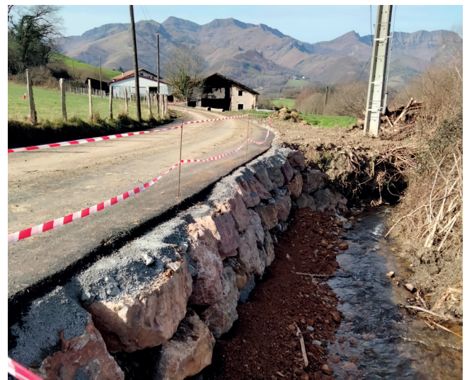
Aparain erreko bidea obren ondotik - Aparain erreko bidea après les travaux
