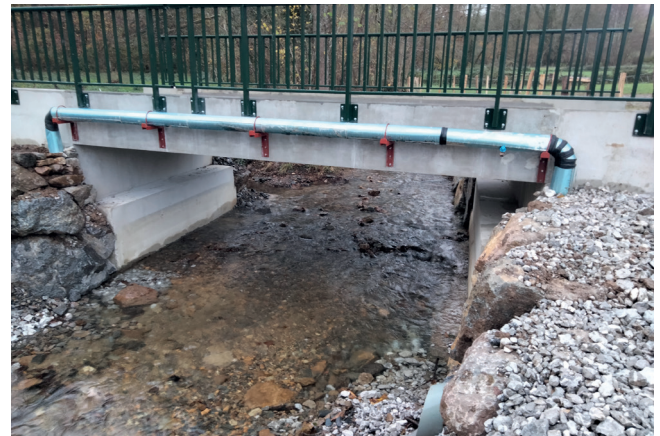
Germietako zubia ekaitzaren ondotik - Pont Germieta après les travaux
